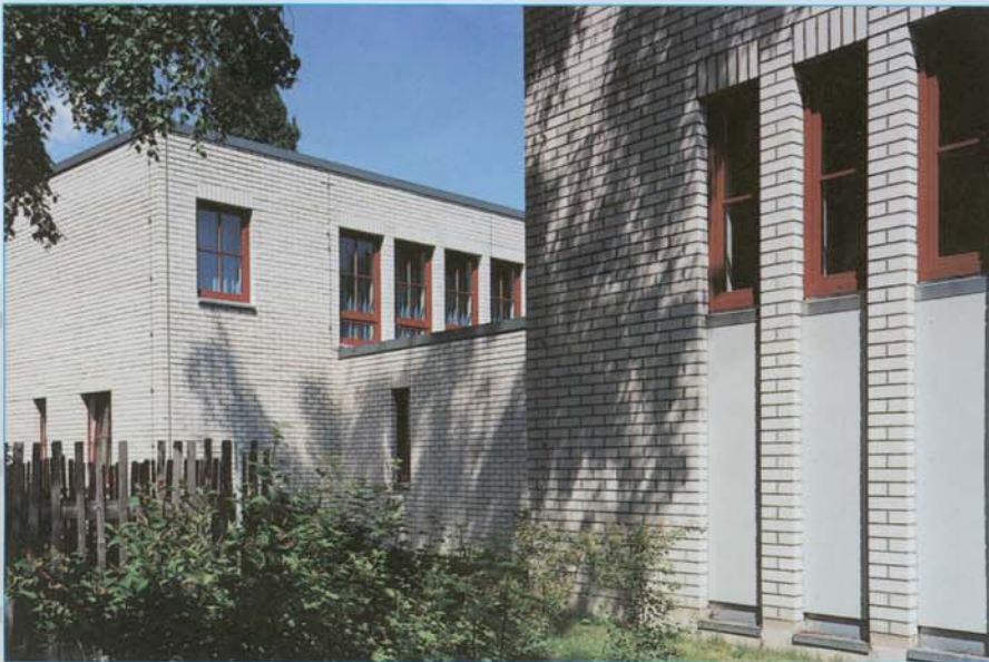
Weißes KS-Sichtmauerwerk – strukturiert durch dunkle Fugen, im Kontrast zu den dunkelroten Fenster- und Türelementen – Ästhetik und Funktionalität im Einklang
