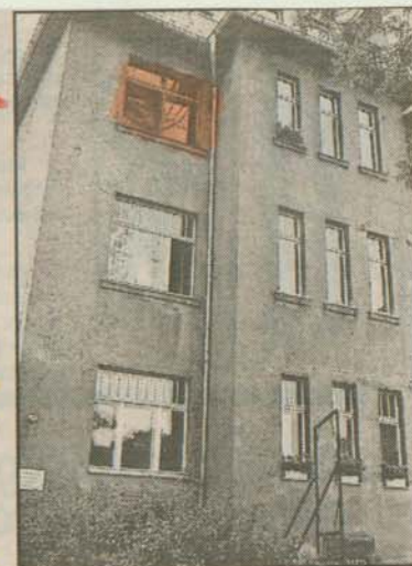
Das Haus Schulstraße 27 in Chemnitz. Hier brannte eine Wohnung im zweiten Stock völlig aus, ein Rentner starb. Feuerursache: ein defekter alter Kühlschrank. Foto: Klaus Jedlicka
